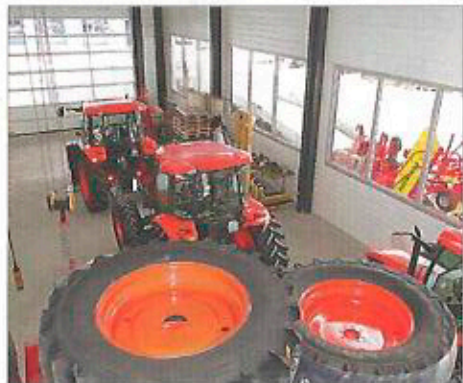
Neue Montagehalle mit Kranbahn.
