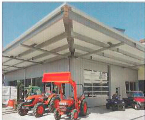
Die neue Montagehalle.
