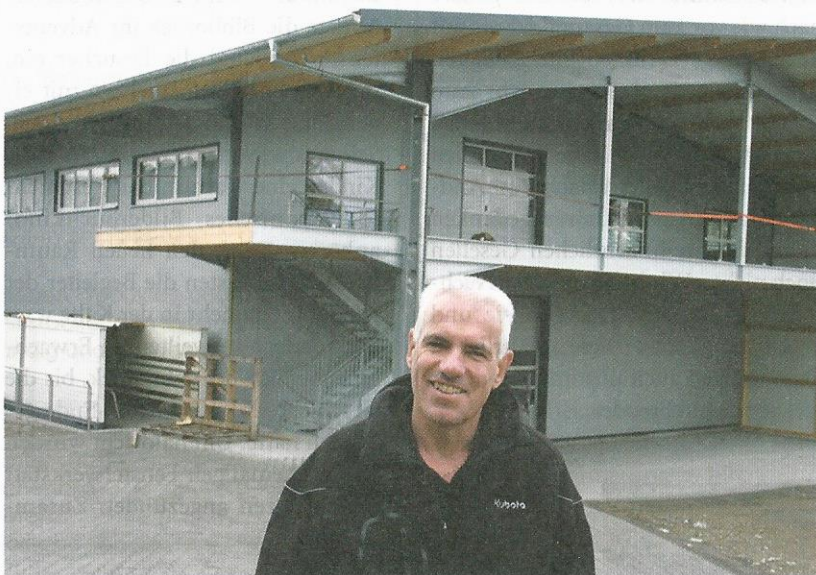
Kurt Bachmann ist Verkaufsleiter. Im Hintergrund die aufgestockte Halle mit Vorplatz und Vordach.
